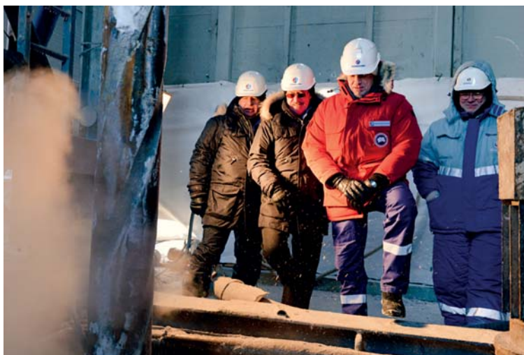
Начало строительства второй эксплуатационной скважины для добычи трудноизвлекаемого туронского газа на Южно-Русском месторождении / Starting Construction of Second Production Well for Extraction of Hard-to-recover Turonian Gas at the Yuzhno-Russkoye Gas Field
