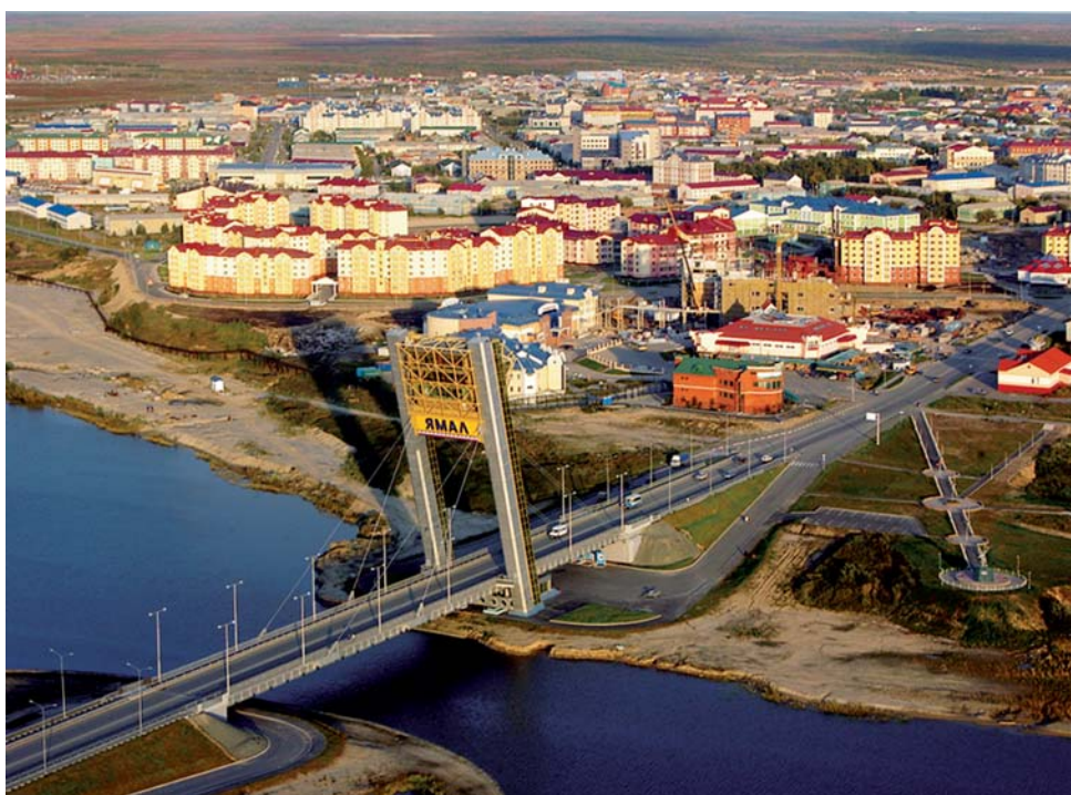
Автодорожный мост «Факел», г. Салехард / «Fakel» road bridge, Salekhard
