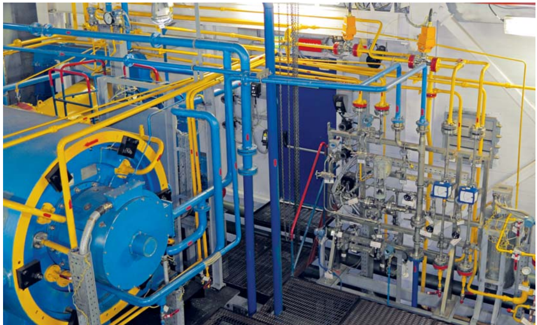
Система управления технологическими потерями газа после сухих газодинамических уплотнений газоперекачивающих агрегатов / Process Gas Losses Management System after Dried Gas Seals of Gas Compressor Units
